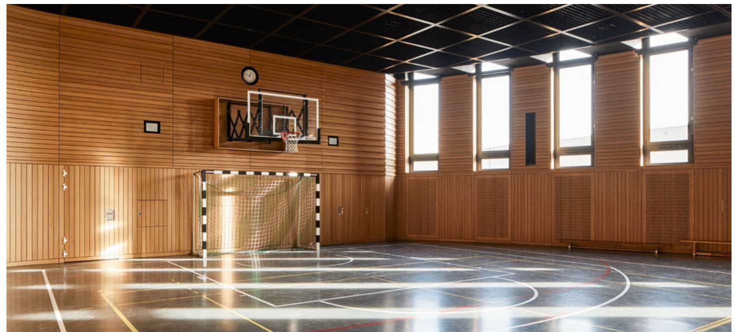
天花板与墙面兼具隔声功能，旨在使声波在其表面发生折射，以避免体育课时音量过高。
