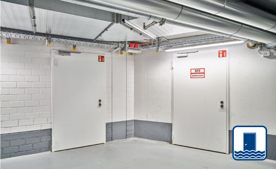
这些单扇钢质工程门可抵御高达 900 毫米水位的洪水。
