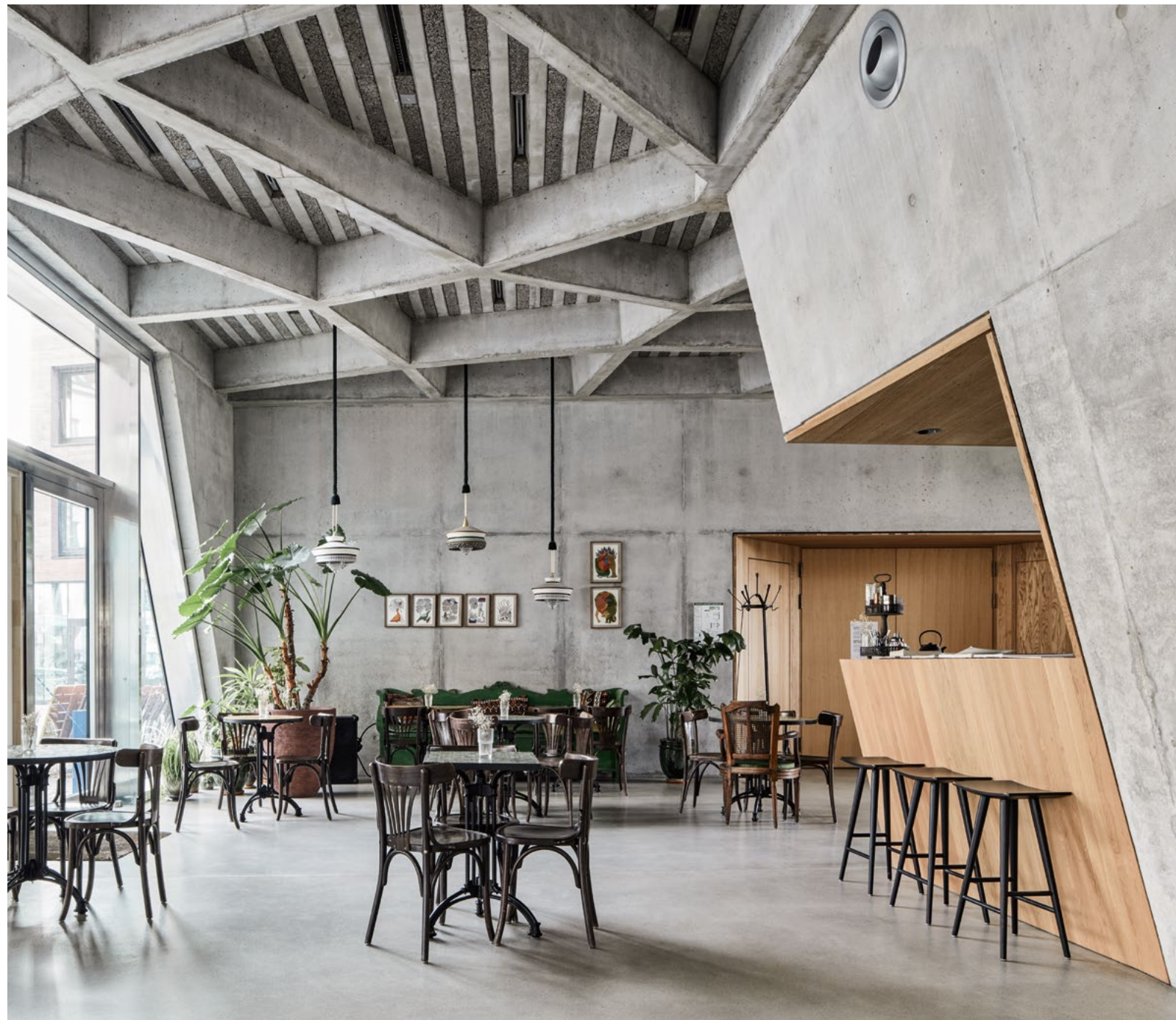
肋状结构体现了混凝土天花板的力的传递路径。
