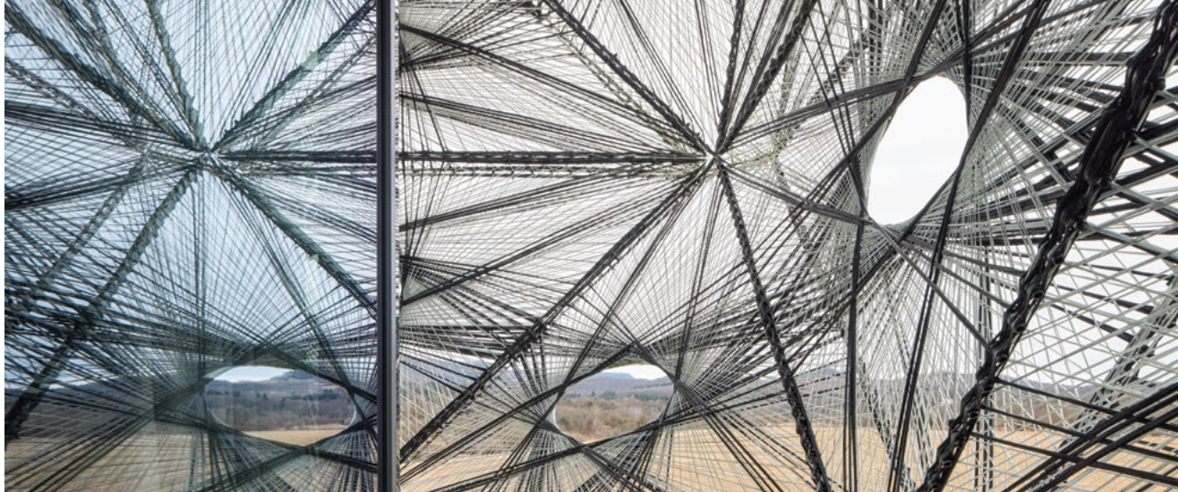
由机器人缠绕而成的外立面构成了 Texoversum 的表层，与内层立面保持一定间距。
