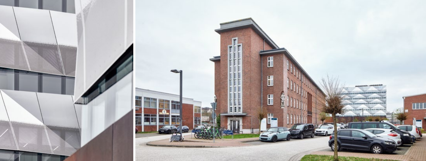
从远处看，外墙让人联想到风帆；从近处看，折叠和部分穿孔的金属板清晰可辨。
