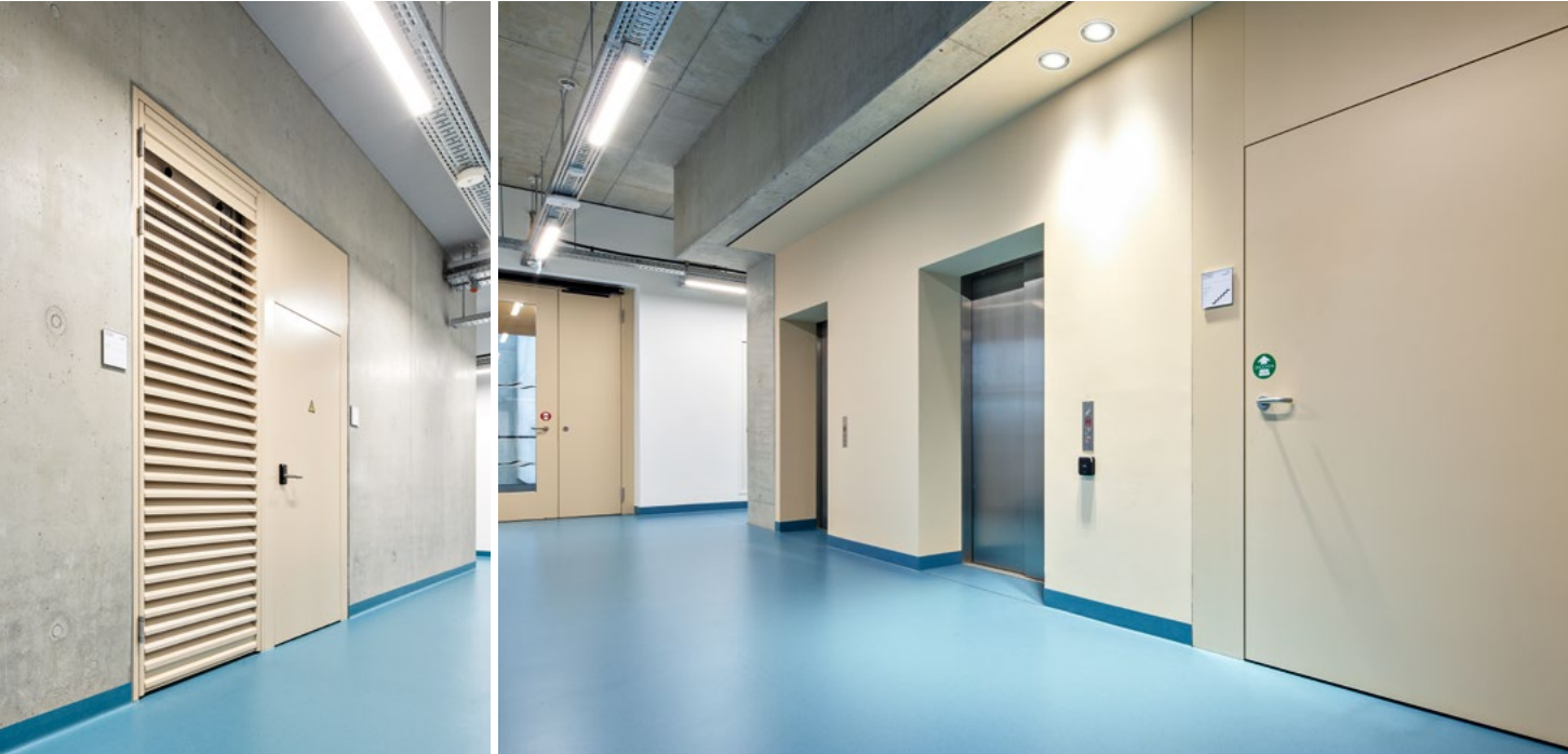
出于技术考量而设置的通风槽。
