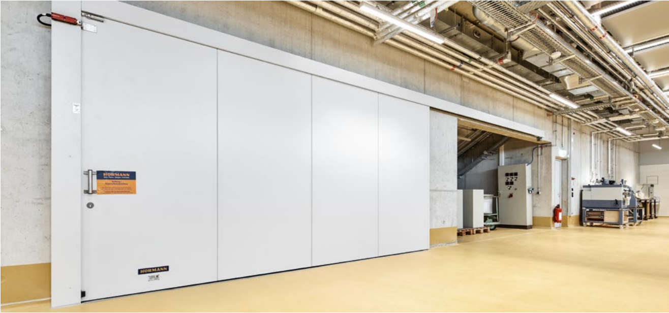
受保护的防火分区：货梯位于推拉式防火门之后。
