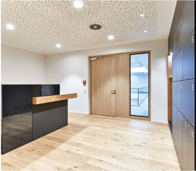
尤为美观：齐平固定玻璃隔断。
